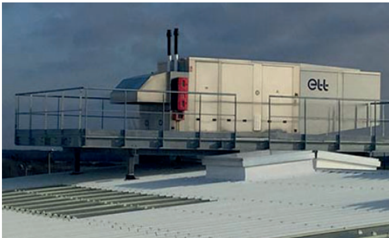
CTA CC+ pour ventilation et chauffage hall de production
