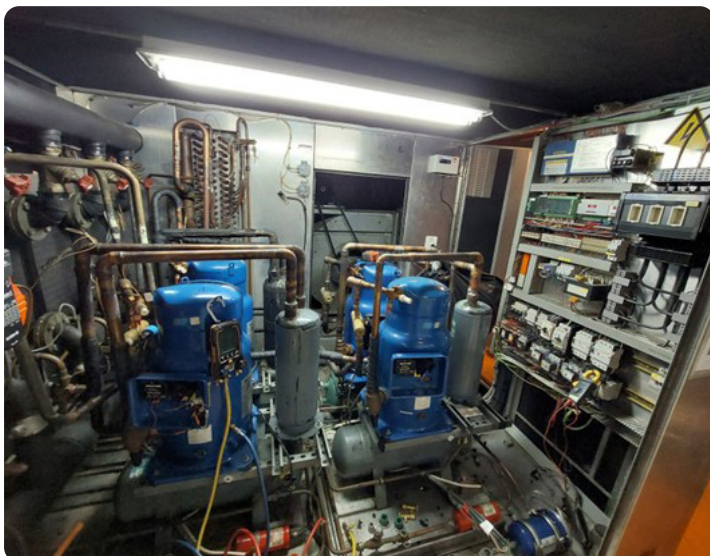
Installation avant la remise en état
