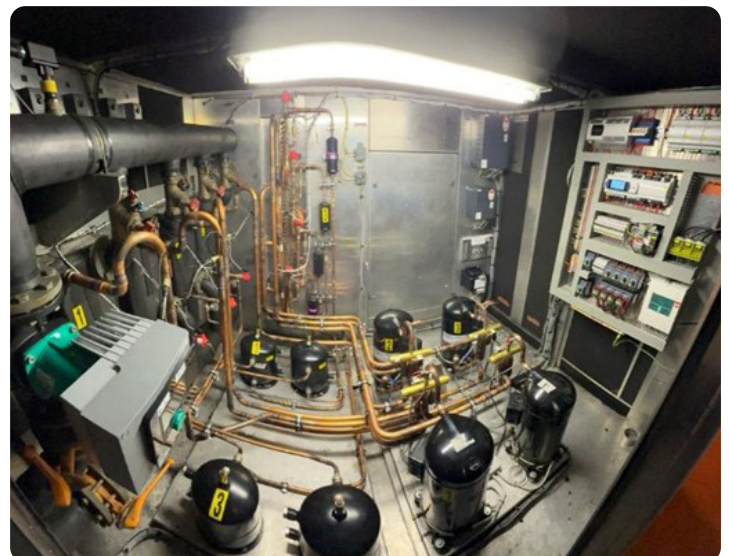
Installation après la remise en état
