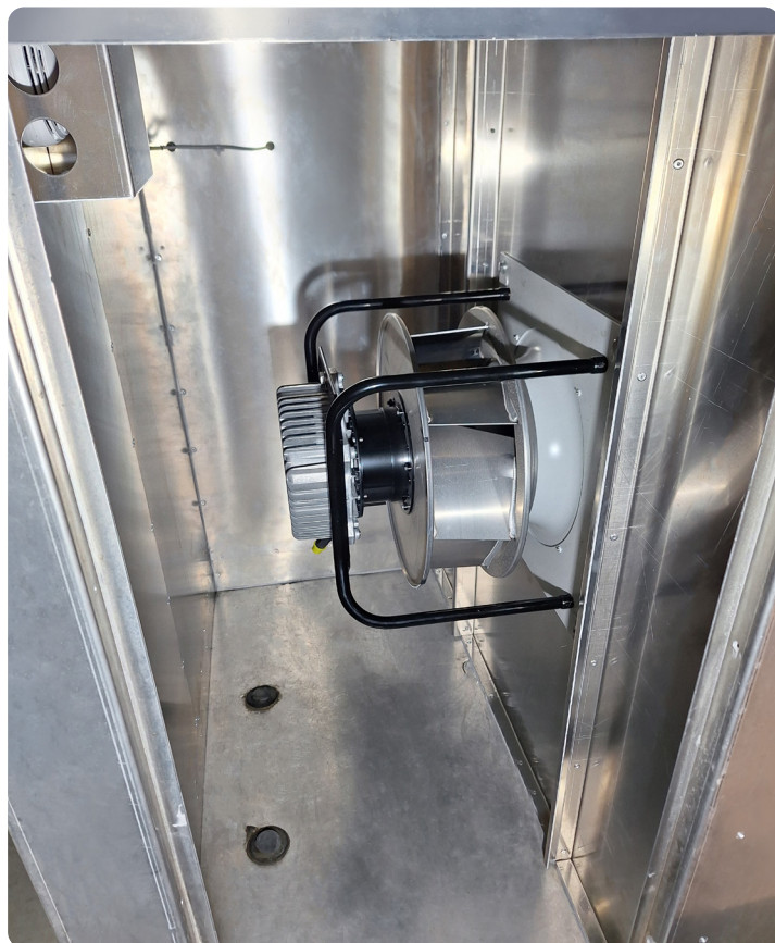
Moto-ventilateur de type « EC » à entraînement direct
