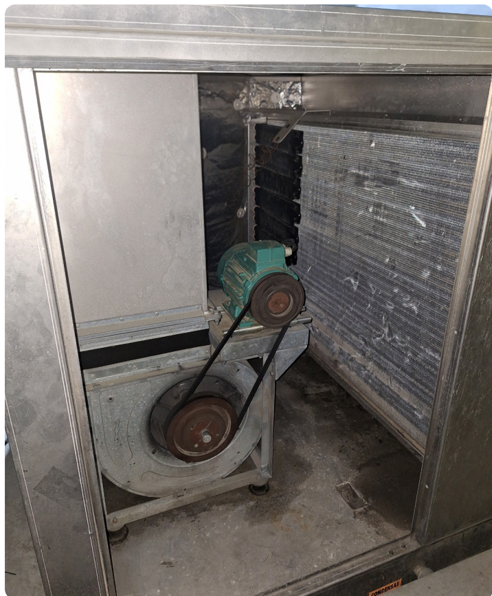
Moto-ventilateur vétuste de type « poulie-courroie »
