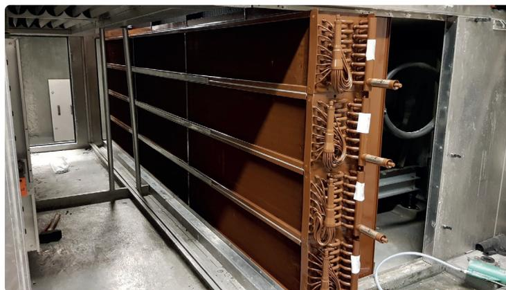
Batterie avec protection anti-corrosion Heresite
