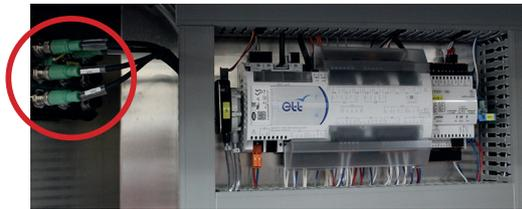
▶ Raccordement de l'ensemble des composants de la machine sur un bus de communication
