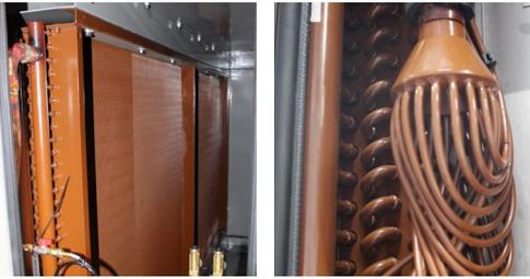
**Protection Hérésite** sur l'ensemble de la batterie et du cadre support
