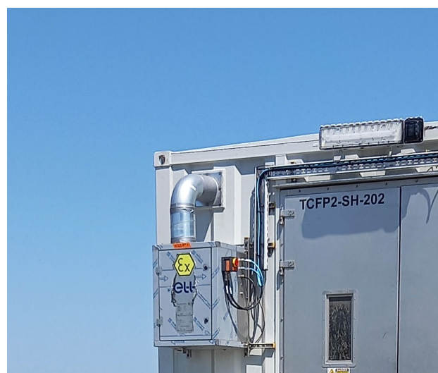
PROJECT N° 16549 – PRESSURISATION UNIT 250 m 3 /h
