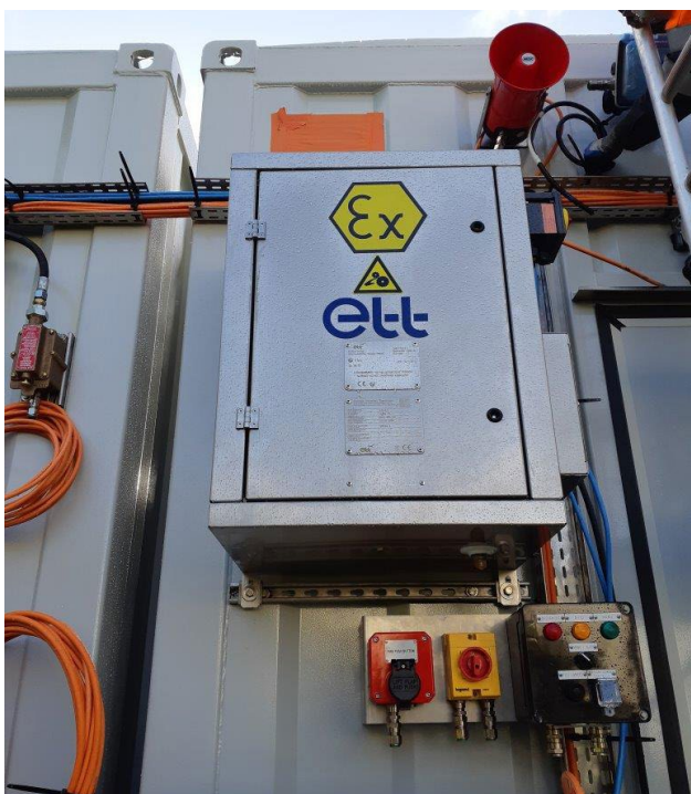
PROJECT N° 15582 – PRESSURISATION UNIT 200 m 3 /h
