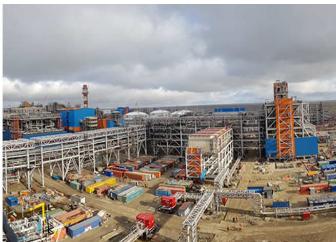
Prace budowlane w Rosji
