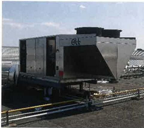
Sur le site de Toulouse, 5 machines de 20 000 m<sup>3</sup>/h et 110 kW de chaud et froid ont été installées.
