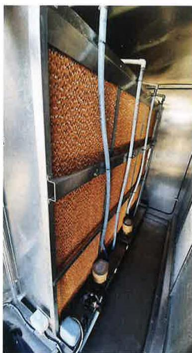
**Le média adiabatique contenu dans les systèmes ETT est constitué de fibre de verre classée M0. Les pertes de charge (60 Pascal environ) sont très faibles par rapport à l'efficacité (92 %).**
